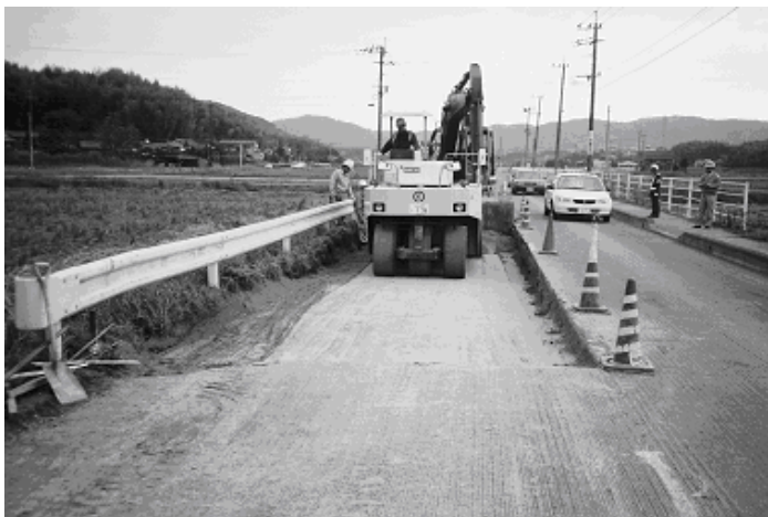
写真 1 福岡県道試験施工
